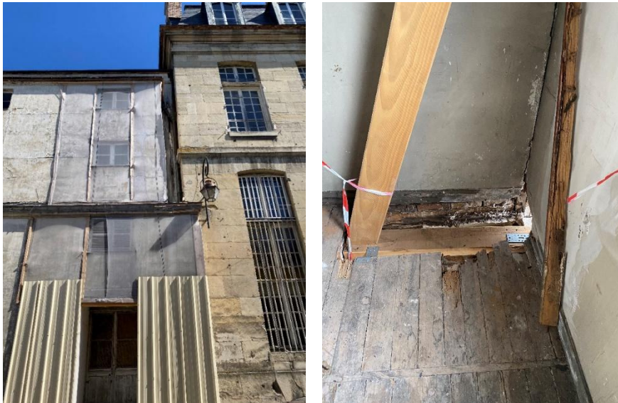
Détail de la partie étayée des galeries Détails des zones étayées à l'intérieur des galeries
