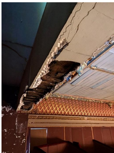
Sous-face du linteau du poulailler, plâtres effondrés
