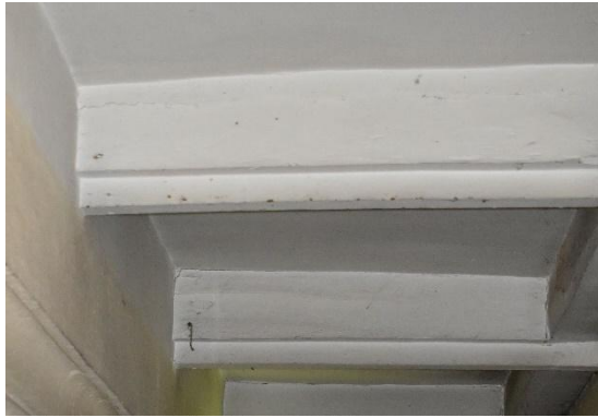
Vestige de la structure métallique qui soutenait les deux niveaux hauts de la galerie
