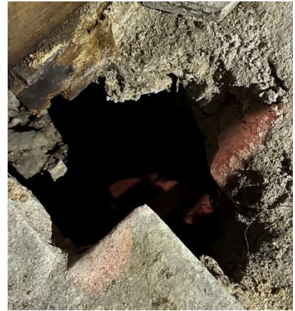
Effondrement du sol au-dessus d'une ancienne citerne
