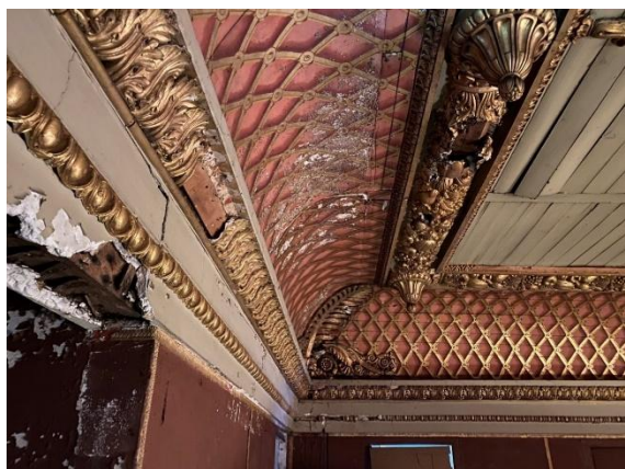
Zones impactées par les infiltrations d'eau
