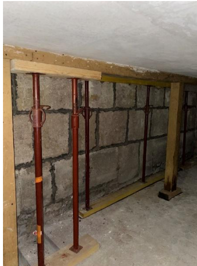
Étalement du plancher haut du RDC et rejointoiement des parements intérieurs en ciment
