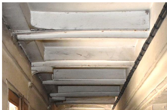
Vestige de la structure métallique qui soutenait les deux niveaux hauts de la galerie
