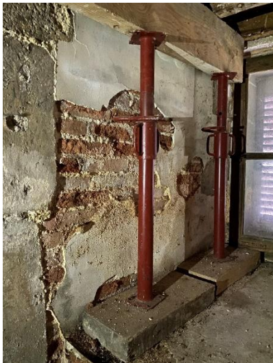
Embrasure de fenêtre étayée au RDC, enduits et briques se délitent
