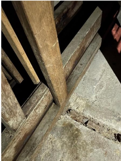
État des lambourdes ancrées dans le Sol
