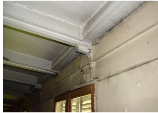
Vestige de la structure métallique qui soutenait les deux niveaux hauts de la galerie
