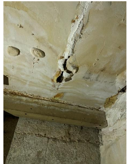
Plafond du foyer, cloquage des plâtres au droit des renforts métalliques
