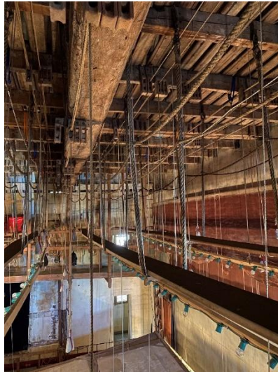
Coursives et passerelles en bois des machinistes, grill en plafond
