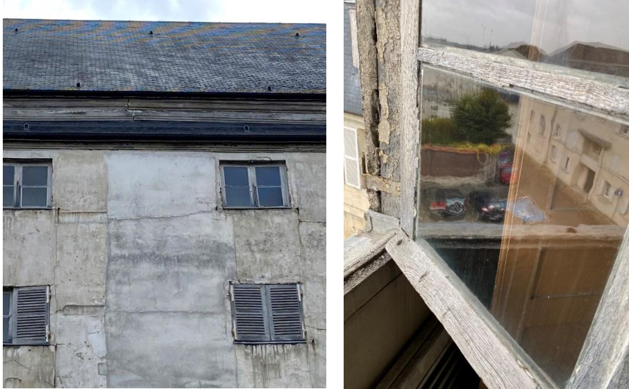
Fissuration importante de l'enduit et état des menuiseries
