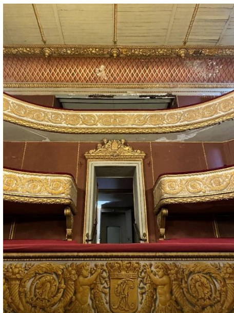
Loge officielle, détail de la toile peinte avec le chiffre des souverains ; en haut à droite, zones impactées par les infiltrations d'eau.
